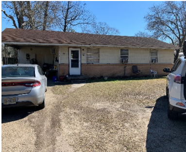
110-AS-01 Shingle/ Roof
