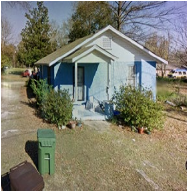
700-AS-01 Shingle/ Roof
