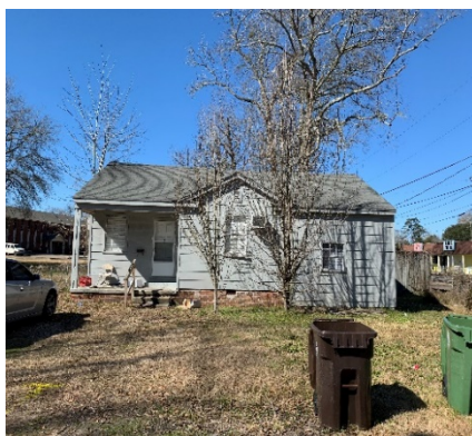
701-AS-01 Shingle/ Roof
